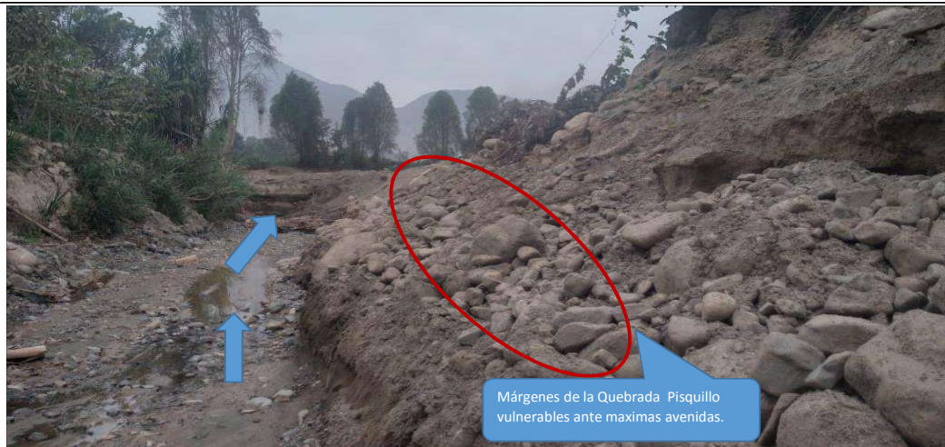
FIGURA N°03: AMBAS MARGENES DE LA QUEBRADA VICHAYCOCHA NO PRESENTA DIQUE DE PROTECCIÓN, OCASIONANDO QUE EL DESBORDAMIENTO DEL CAUCE DEL RIO SEA MAS INMINENTE EN EPOCAS DE AVENIDAS.
