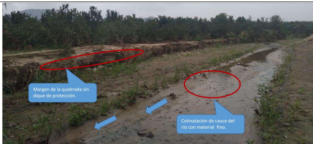
FIGURA N°04: MARGEN DERECHA DE LA QUEBRADA SE ENCUENTRA VULNERABLE POR LO CUAL OCASIONARA INUNDACIONES ANTE POSIBLES AVENIDAS, AFECTANDO A LOS CAMPOS AGRICOLAS ALEDAÑOS.
