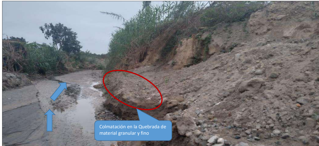
FIGURA N°02: QUEBRADA PISQUILLO COLMATADO EN EL SECTOR PISQUILLO, CON LA PRESENCIA DE MATERIAL GRANULAR Y MATERIAL FINO SEDIMENTADO; LAS CUALES DEBEN SER DESPLAZADOS HACIA AMBOS MARGENES PARA QUE EL CAUCE MANTENGA SU SECCIÓN HIDRÁULICA.
