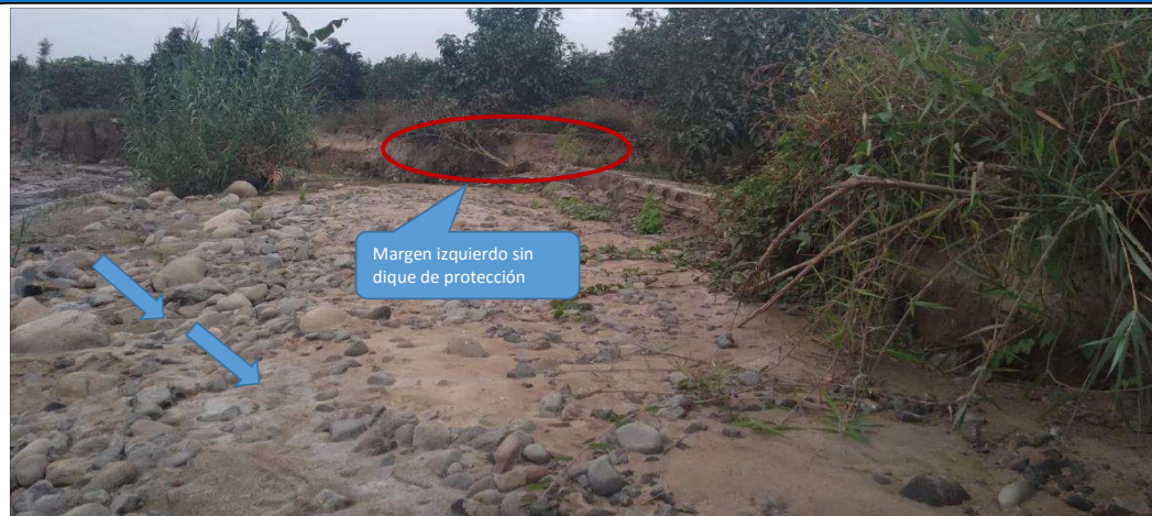
FIGURA N°01: QUEBRADA PISQUILLO SIN PRESENCIA DE DIQUE DE PROTECCIÓN EN EL SECTOR PISQUILLO, POR LO QUE SE ENCUENTRA ANTE EL RIESGO DE DESBORDE AFECTANDO A LAS ÁREAS AGRÍCOLAS ALEDAÑAS.
